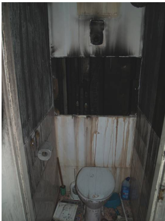
13-14 sz. képek. A VII. emeleti lakás WC helyisége. Annak ellenére, hogy az aknaburkolat középső részét leszerelték, jól látható a lemeztoldásoknál és a WC tartály rögzítőelemeinek helyén a füstszivárgás (fotó: Takács Lajos)
