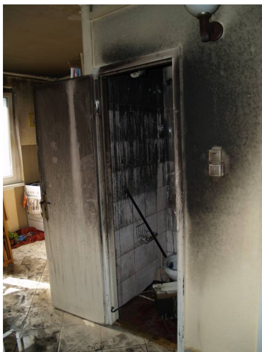
15 sz. kép. A VIII. emeleti lakás WC helyiségének képe az intenzív füstkiáramlás nyomaival (fotó: Takács Lajos)
