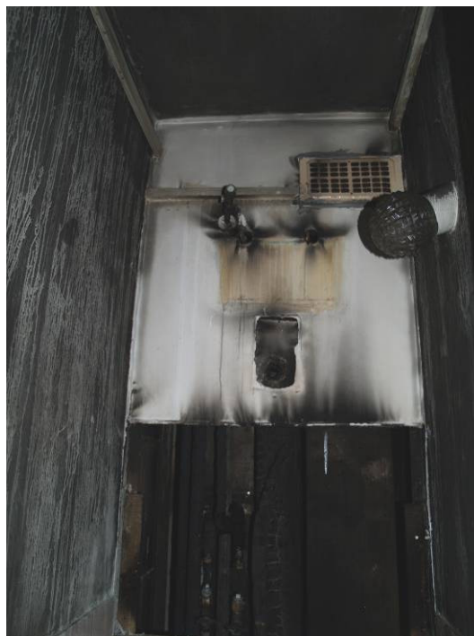
13-14 sz. képek. A VII. emeleti lakás WC helyisége. Annak ellenére, hogy az aknaburkolat középső részét leszerelték, jól látható a lemeztoldásoknál és a WC tartály rögzítőelemeinek helyén a füstszivárgás (fotó: Takács Lajos)
