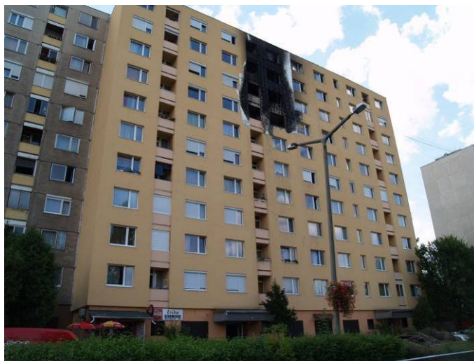
1 sz. kép. Az épület képe a Középszer utca felől (fotó: Takács Lajos Gábor)
