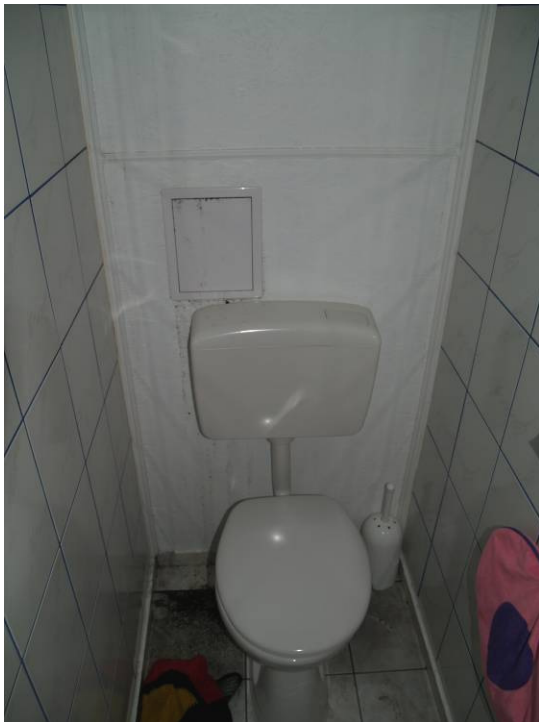
4 sz. kép. A V. emeleti lakás WC hátfala (aknafala). Jól látható az utólagosan, feltehetően a vízórák szerelésekor beépített reviziós nyílás (fotó: Takács Lajos)
