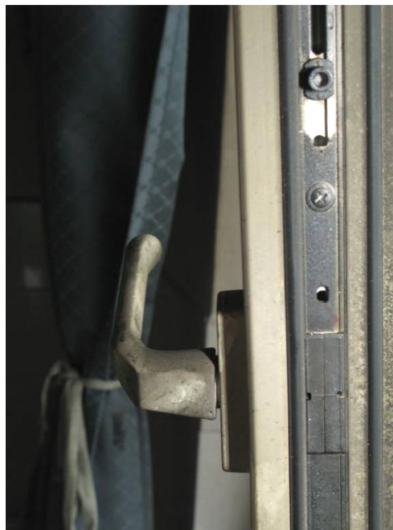
29-30 sz. képek. A VII. emeleti lakás konyhai ablaka és annak zárszerkezete a tűz után. Jól látható, hogy az ablak a tűz idején bukó állásban volt és a kilincset később állították vízszintes helyzetbe (fotó: Takács Lajos – Király András)
