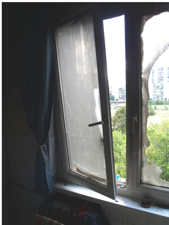
29-30 sz. képek. A VII. emeleti lakás konyhai ablaka és annak zárszerkezete a tűz után. Jól látható, hogy az ablak a tűz idején bukó állásban volt és a kilincset később állították vízszintes helyzetbe (fotó: Takács Lajos – Király András)
