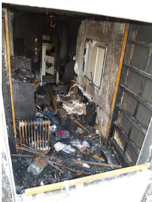
25 sz. kép. A VII. emeleti lakás loggiájának és felszobájának képe a homlokzat felől, a Tűzoltóság kosaras szeréből fényképezve. Jobboldalt a loggia oldalsó burkolatának faváza látható (fotó: Takács Lajos)
