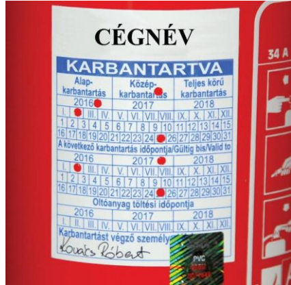
Karbantartást igazoló címke felhelyezése OKF azonosító jellel
